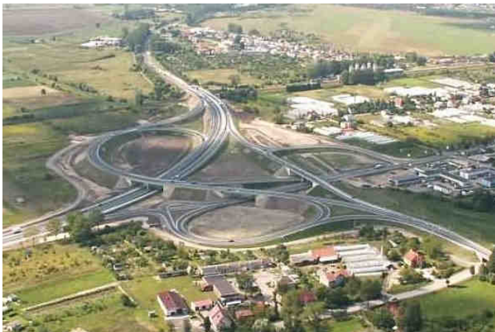
Zdjęcie 4. Fragment odcinka remontowanego drogi krajowej nr 7 Jazowo – Elbląg
